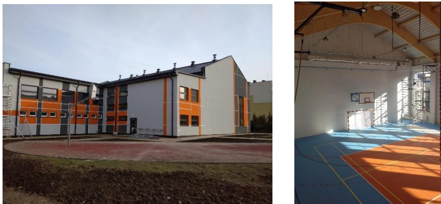
Rysunek 22. Sala gimnastyczna przy SP Nr 1 w Hrubieszowie.
