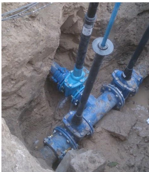
Rysunek 34. Budowa sieci wodociągowej w ul. Wiśniowej w Hrubieszowie.
